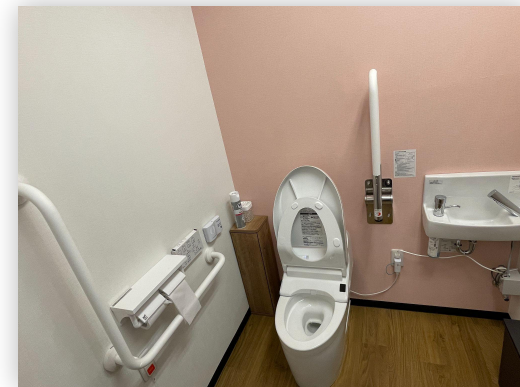
手すりの設置・非常事態ボタンの設置
