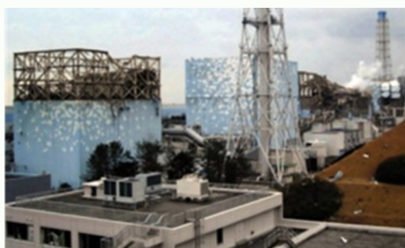
廃炉解体作業が続く 第一原発
